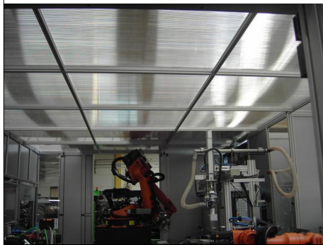
Robotereinhausung mit Decke
